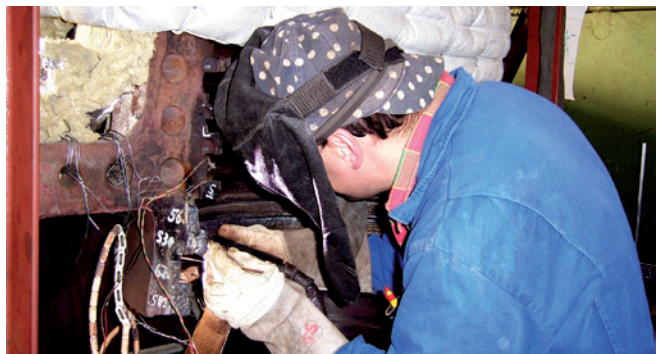
Auftragsschweißen eines Turbinengehäuses unter zusätzlicher Wärmebringung
